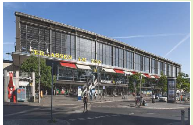
Terrassen am Bahnhof Zoo, Berlin - Sanierung 700 m 2 Ziegel-Einhängedecke 21+6 / 13+6
