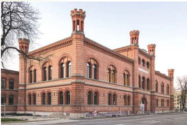
Hochschule Lothstraße, München - Sanierung und Erweiterung 415 m 2 Ziegel-Einhängedecke 18+7
