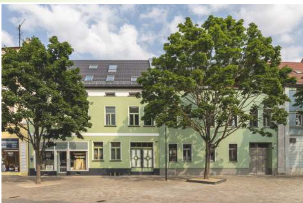
Markt, Schönebeck - Umbau Wohnhaus 250 m 2 Ziegel-Einhängedecke 18+6
