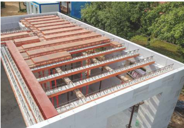
... danach die Deckenziegel eingehängt ...
