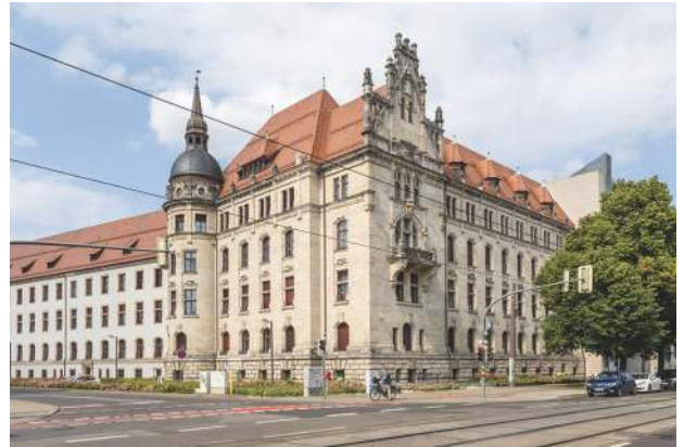
Landgericht, Magdeburg - Sanierung Altbau 700 m 2 Ziegel-Einhängedecke 21+3 / 18+7
