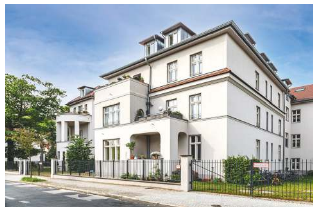
Rembrandtstraße, Potsdam - Umbau eines Wohnhauses 2700 m 2 Ziegel-Einhängedecke 21+4
