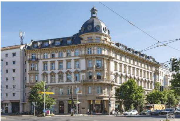
Chausseestraße, Berlin - Dachgeschoßumbau 640 m 2 Ziegel-Einhängedecke 18+7
