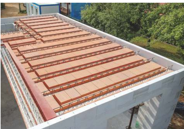
... schließlich kann der Vergussbeton eingebracht werden - fertig!
