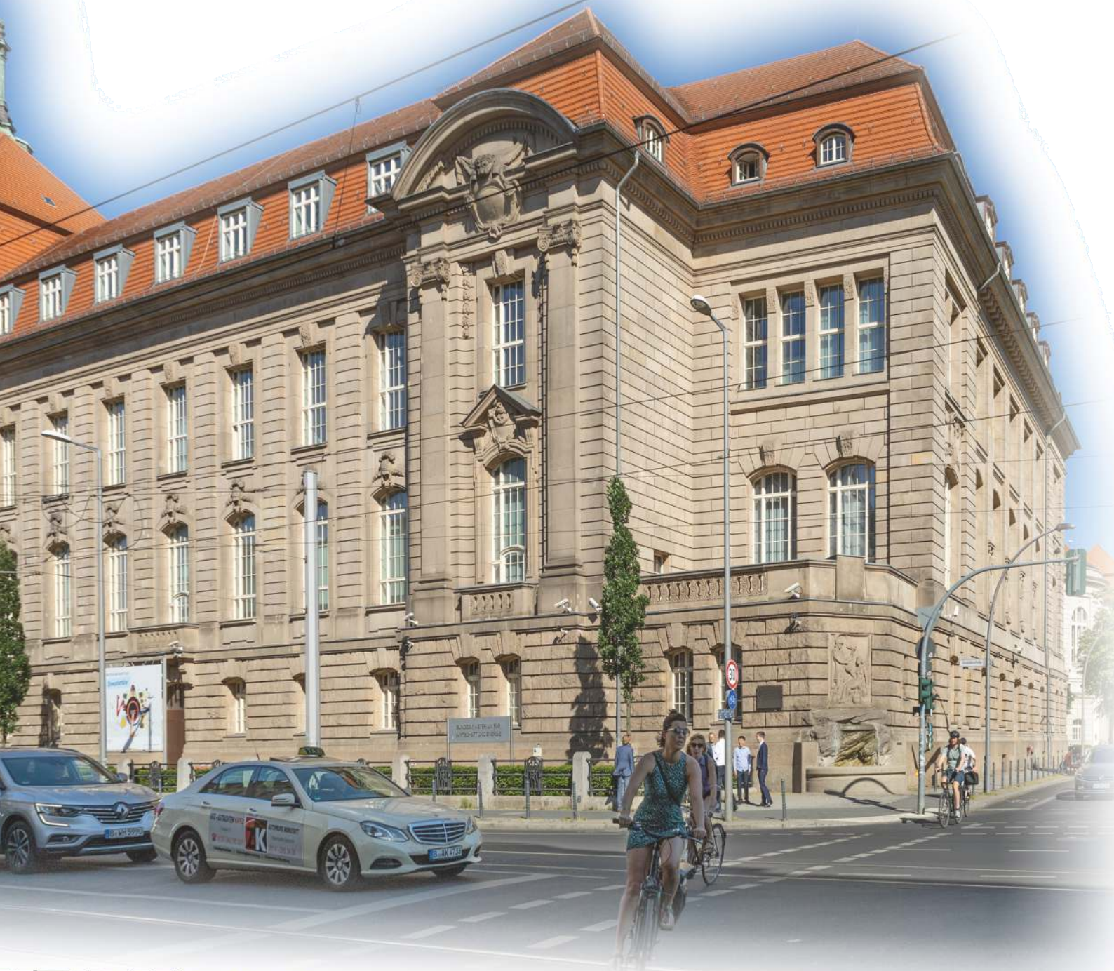
Bundeswirtschaftsministerium, Berlin Einbau von Ziegel-Einhängedecken im Zuge der Brandschutzsanierung.
