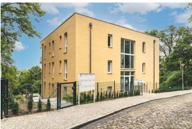
Am Havelblick, Potsdam - Sanierung und Modernisierung einer Villa 330 m 2 Ziegel-Einhängedecke 21+4
