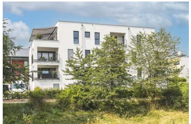
Redwitzweg, Marktrechwitz - Neubau Mehrfamilienhaus 170 m 2 Ziegel-Einhängedecke 16+6
