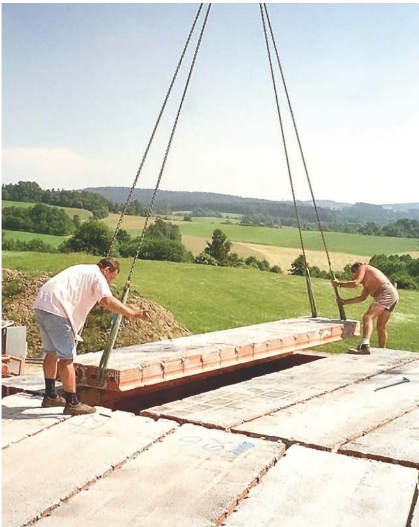
... und können mit dem Kran sofort verlegt werden. So entsteht in wenigen Stunden eine komplette, voll belastbare Geschoßdecke.
