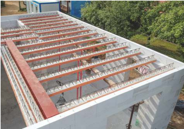
Zunächst werden die Deckenträger aufgelegt und eingemessen ...
