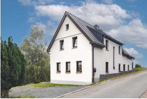
Klingenthal - Sanierung und Anbau Wohnhaus 75 m 2 Ziegel-Einhängedecke 25+0
