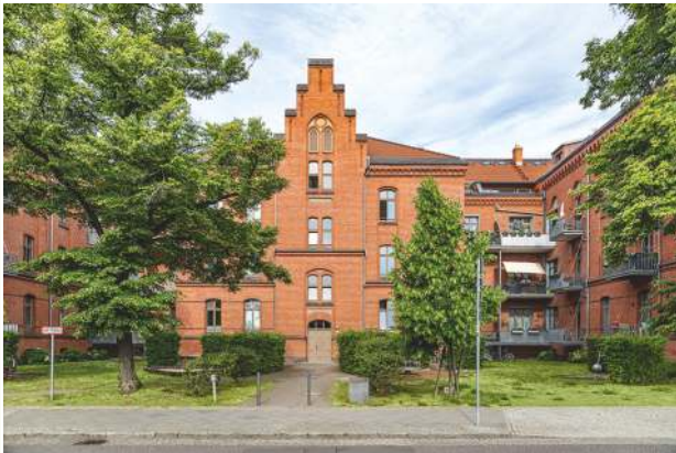
Rote Kaserne, Potsdam - Umbau und Sanierung 1400 m 2 Ziegel-Einhängedecke 18+7
