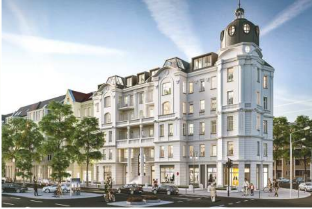
Kurfürstendamm, Berlin - Ausbau Dachgeschoß 745 m 2 Ziegel-Einhängedecke 25+0 / 25+6 Dr. Krause Architekturbüro
