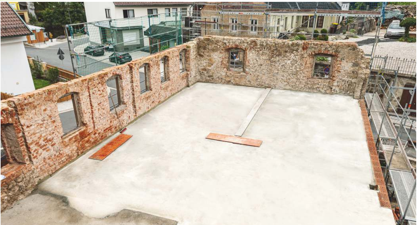
Die Fiedler Ziegel-Einhängedecke mit glattgezogenem Aufbeton.
