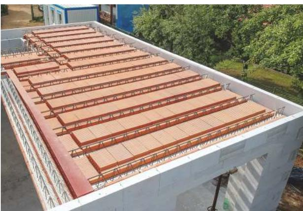
... schließlich kann der Vergussbeton eingebracht werden
