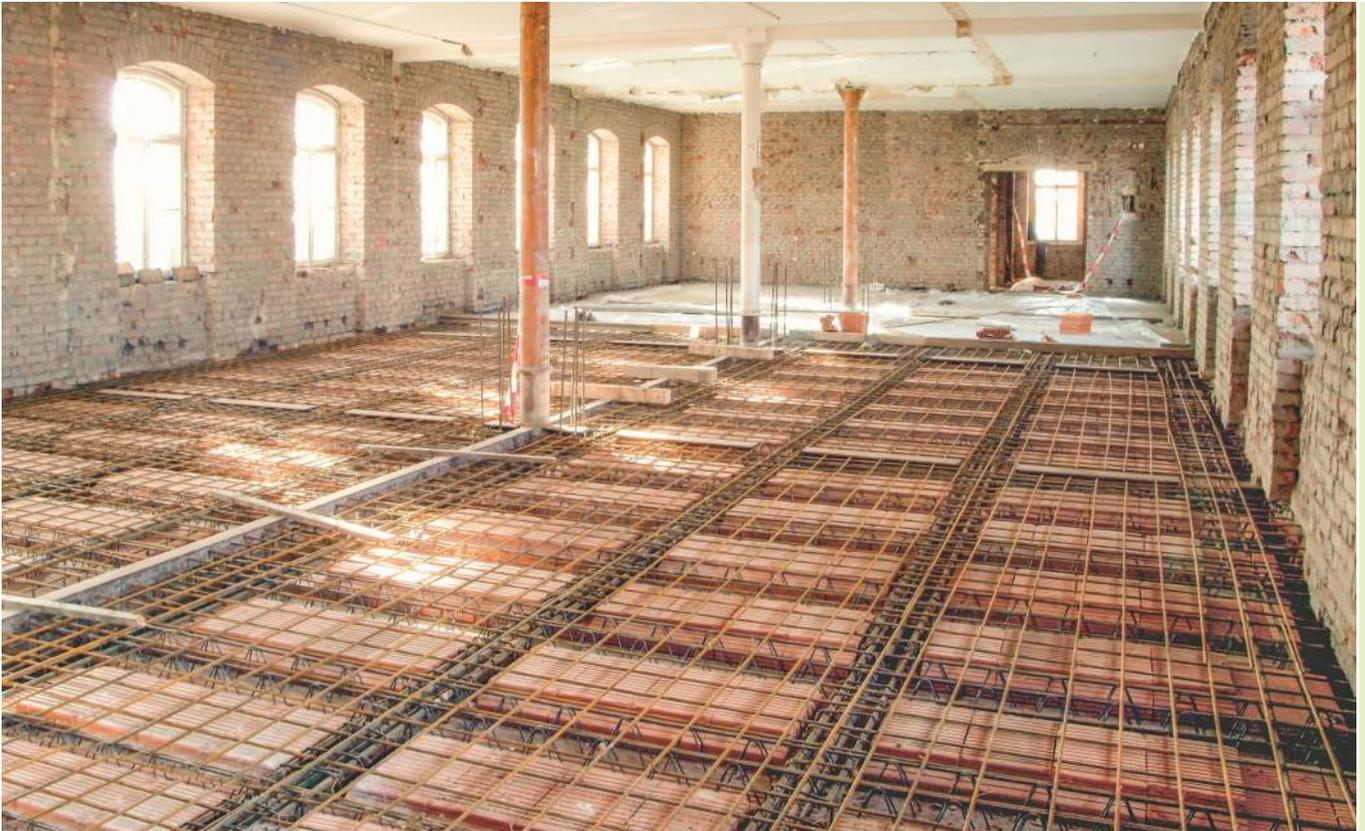
Doppelträgerdecke mit Querrippen- und Aufbetonbewehrung für große Spannweiten und hohe Belastungen.
