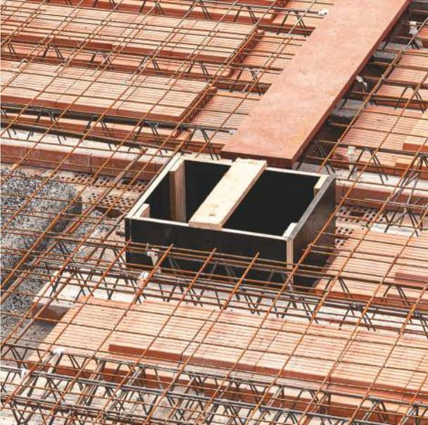
Größere Durchbrüche in einer Fiedler Ziegeldecke, wie z.B. Kamine, Treppen oder Aufzüge, werden bereits im Verlegeplan berücksichtigt. Sie werden in der Regel durch den Einbau von Wechselträgern ausgeführt.
