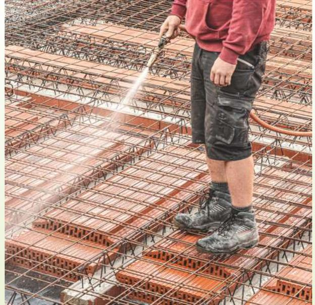
Damit ein korrektes Abbinden des Betons erreicht werden kann, müssen die Deckenziegel vor dem Einbringen des Vergussbetons gründlich gewässert werden.
