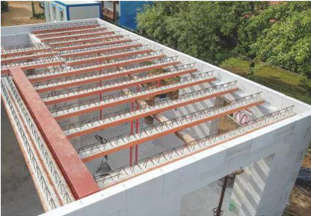
Zunächst werden die Deckenträger aufgelegt und eingemessen ...
