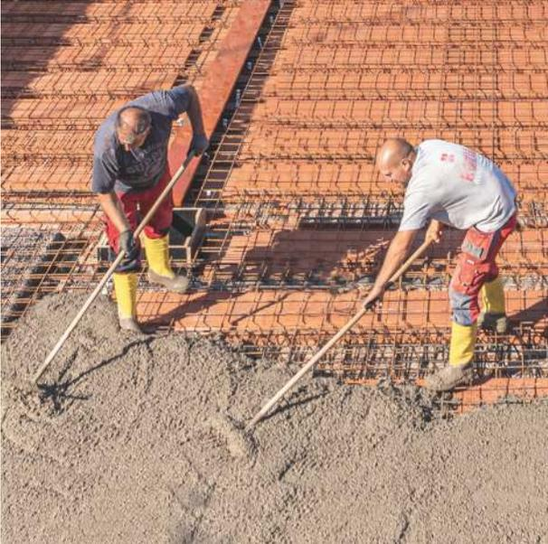
Der Vergussbeton C25/30 (Größtkorn 16 mm) wird in einem Arbeitsgang eingebracht und glatt abgezogen. Es muss auf ausreichende Verdichtung geachtet und die planmäßige Höhe des Aufbetons eingehalten werden. Um den Beton beim Abbinden vor Austrocknung und damit verbundener Rissbildung zu schützen, muss er einige Tage mit Folie abgedeckt bzw. regelmäßig mit Wasser besprüht werden.
