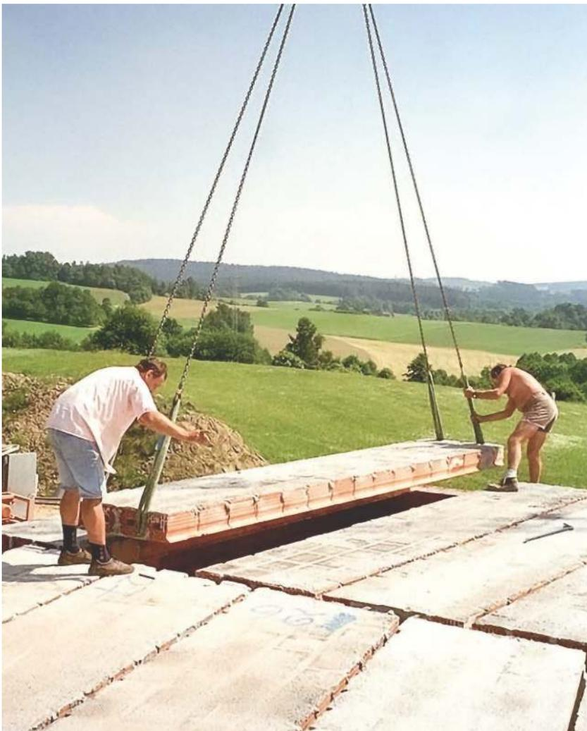
... und können mit dem Kran sofort verlegt werden. So entsteht in wenigen Stunden eine komplette, voll belastbare Geschoßdecke.
