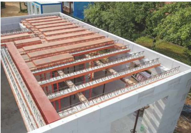
... danach die Deckenziegel eingehängt ...
