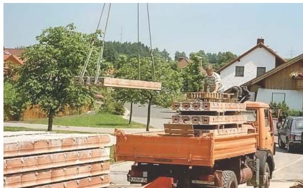
Die Ziegeldecken-Elemente werden fix und fertig „just-in-time“ auf der Baustelle angeliefert ...
