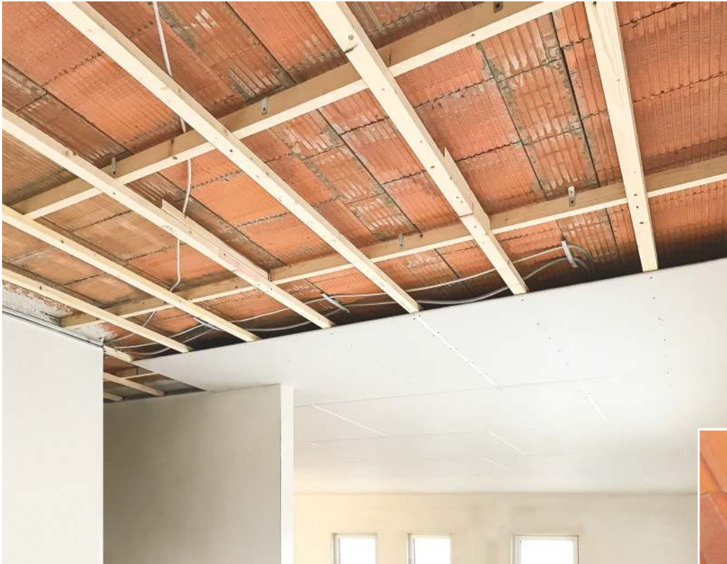
Direkte Verschraubung einer Unterkonstruktion aus Holzlatten am integrierten Abhängesystem.
