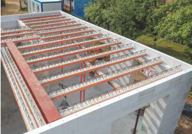
Zunächst werden die Deckenträger aufgelegt und eingemessen ...
