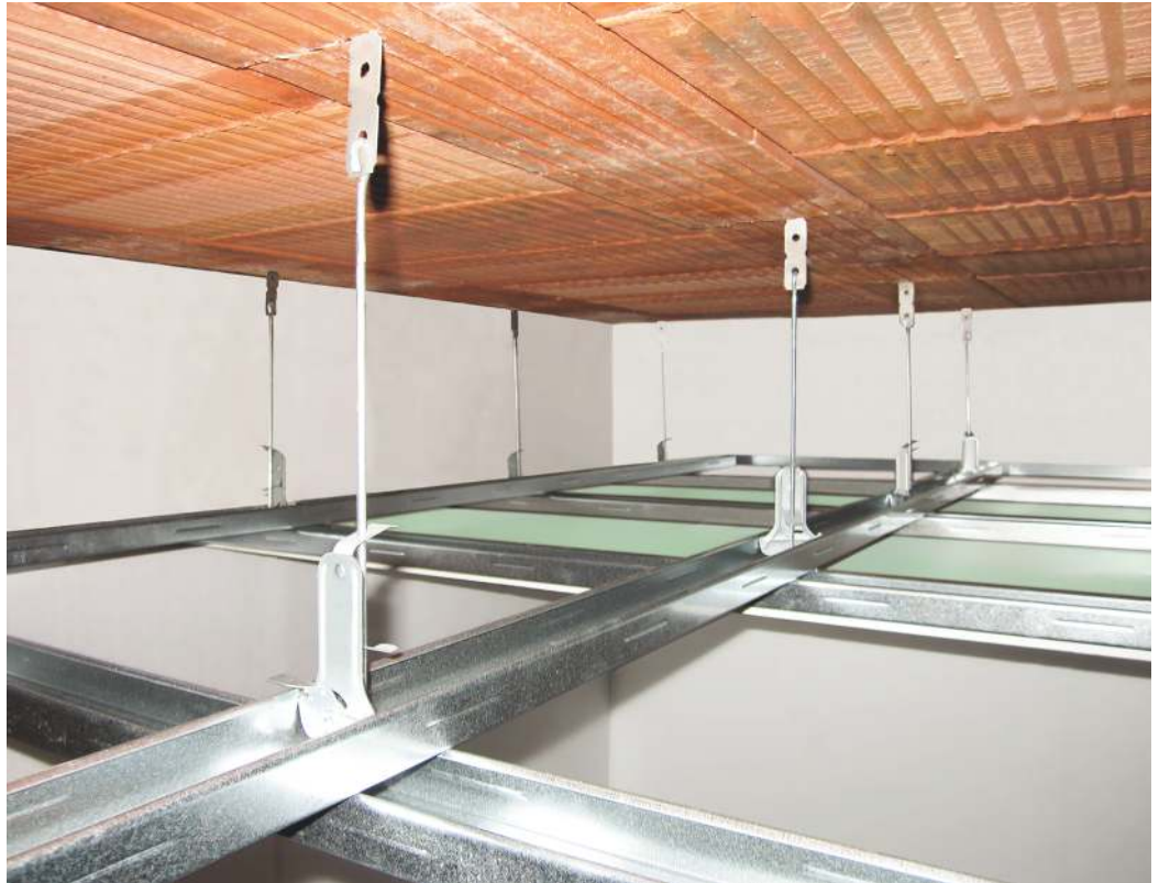
Befestigung einer Metall-Unterkonstruktion mittels Abhängedrähten am integrierten Abhängesystem.
