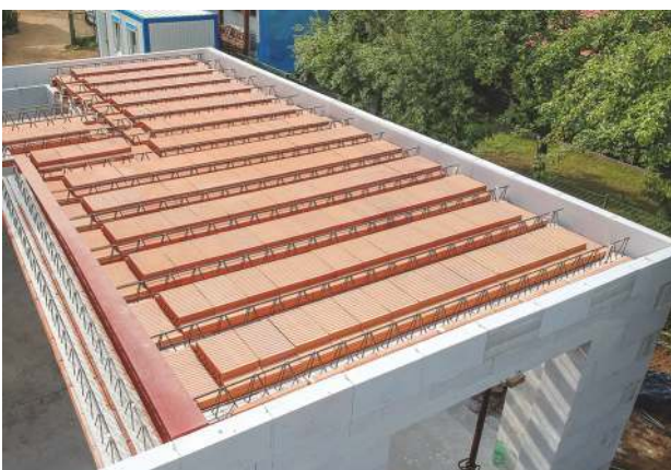
... schließlich kann der Vergussbeton eingebracht werden - fertig!
