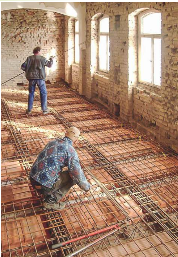
Ideal für die Altbausanierung: Geringe Größen und Gewichte der einzelnen Bauteile.
