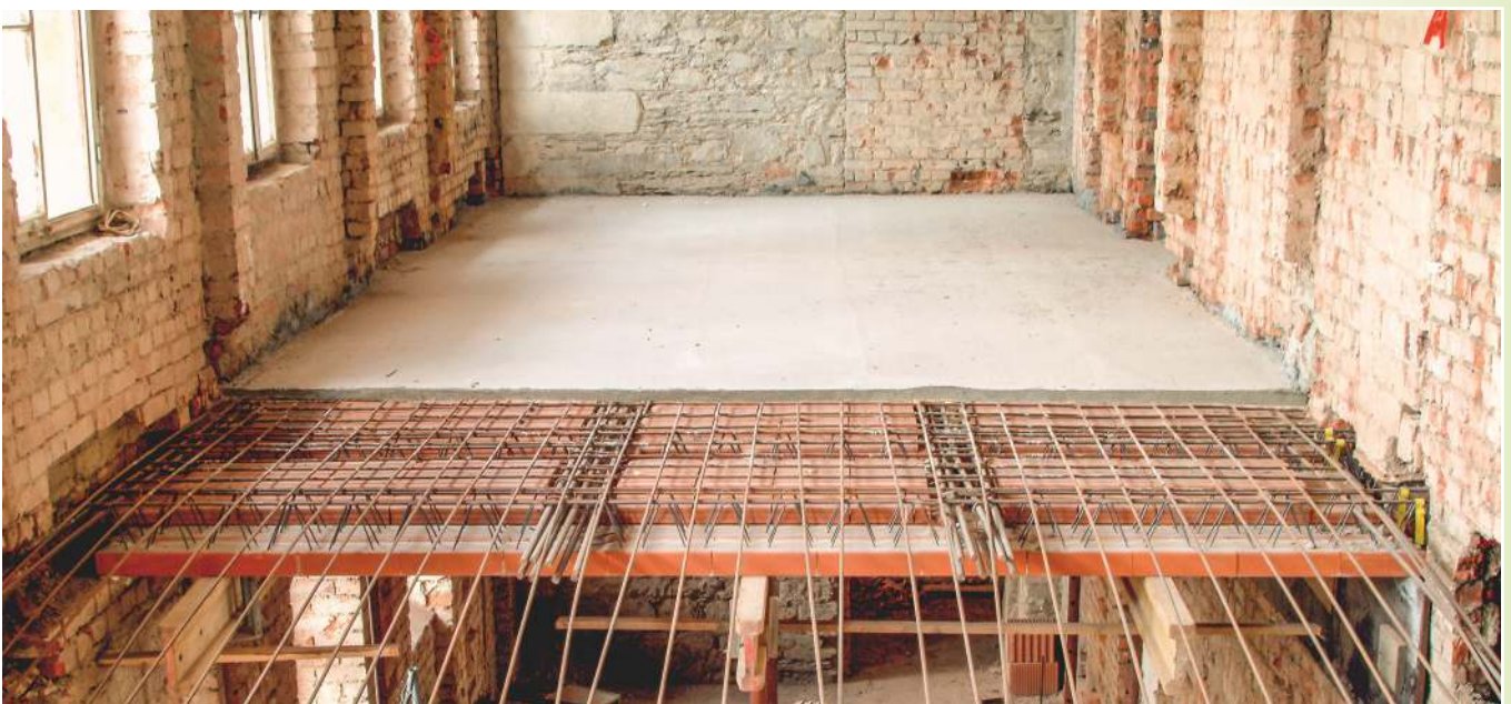
Ziegel-Einhängedecken sind der ideale Ersatz für marode Holzdecken bei der Altbausanierung. Sie können abschnittsweise eingebaut werden und verbessern zusätzlich die Stabilität der vorhandenen Bausubstanz.
