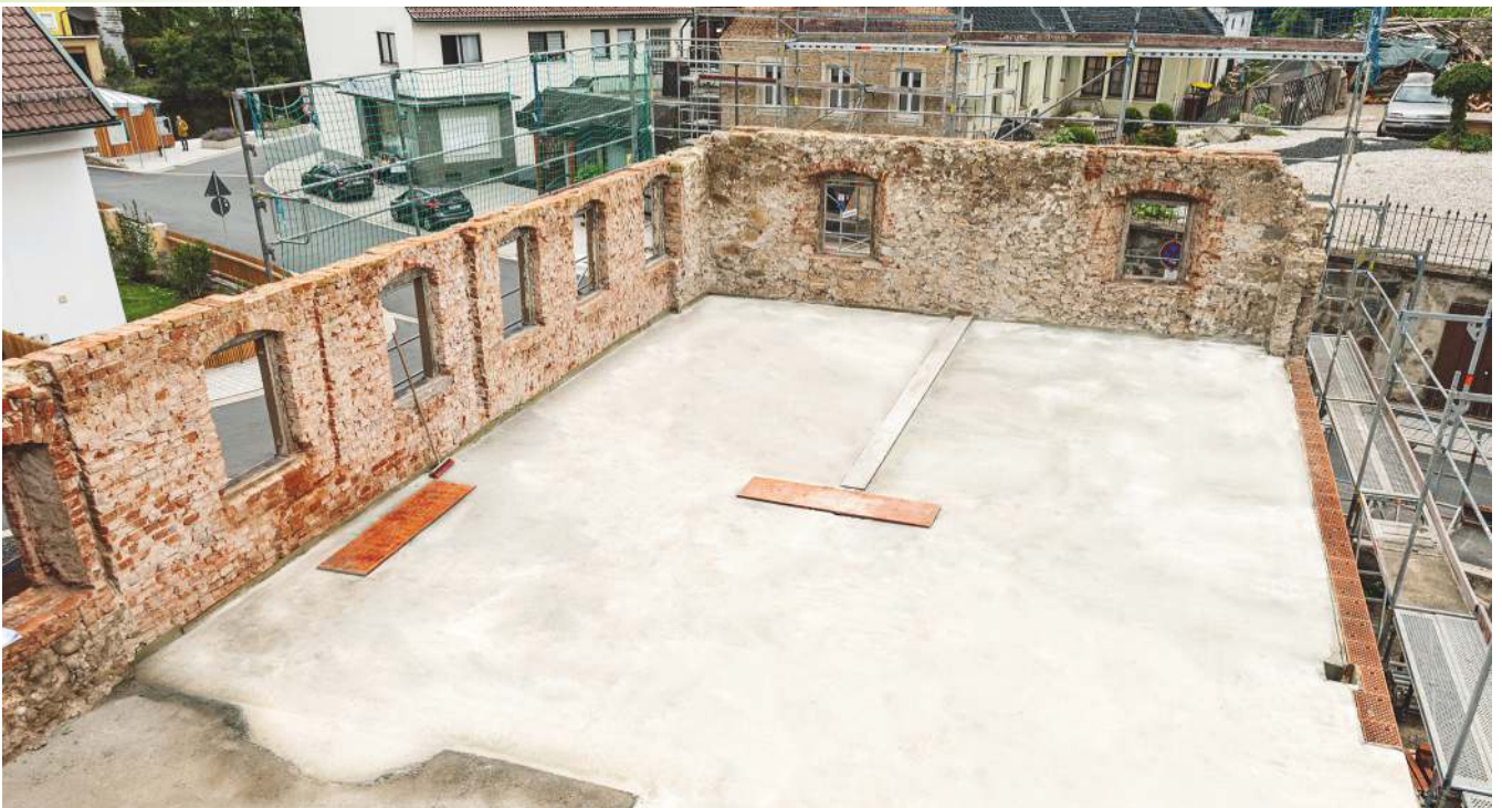
Die Fiedler Ziegel-Einhängedecke mit glattgezogenem Aufbeton.
