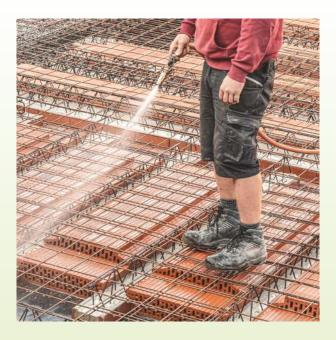
Damit ein korrektes Abbinden des Betons erreicht werden kann, müssen die Deckenziegel vor dem Einbringen des Vergussbetons gründlich gewässert werden.
