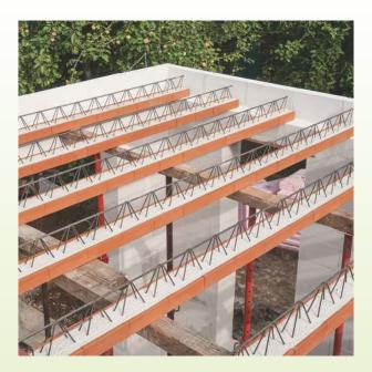
Beim Verlegen der Deckenträger ist darauf zu achten, dass - wenn nicht anders angegeben - jeweils eine Mindestauflagertiefe von 12 cm erreicht wird. Die Lage des ersten Trägers, die Verlegefolge und das Rastermaß sind im Verlegeplan vorgegeben. Bevor die Deckenziegel verlegt werden, sind - je nach Deckentyp - alle 1,7 - 2 m Montageunterstützungen einzuziehen.
