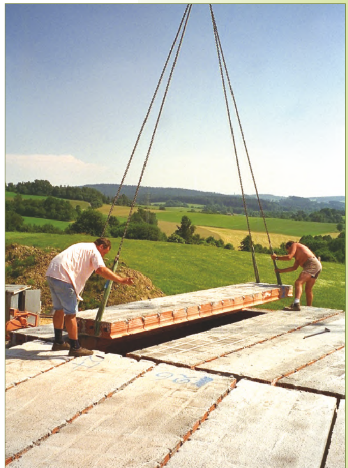
... und können mit dem Kran sofort verlegt werden. In wenigen Stunden entsteht eine komplette, voll belastbare Geschößdecke.
