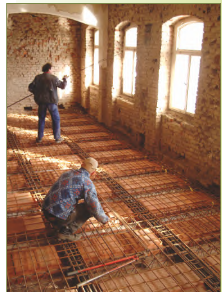
Ideal für die Altbausanierung: Geringe Größen und Gewichte der einzelnen Bauteile.
