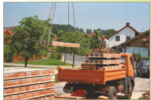
Die Ziegeldecken-Elemente werden fix und fertig "just-in-time" auf der Baustelle angeliefert ...
